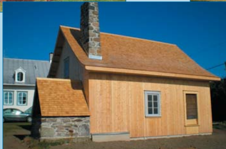
Le fournil pendant la restauration
