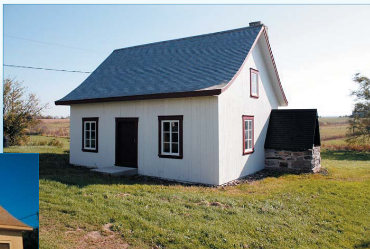
Le fournil après sa restauration
